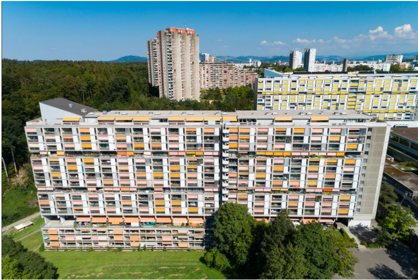
Abbildung 2: Gäbelbach 31-47 (Foto von Martin Rungg, Dr. Meyer Immobilien AG. – 7.11.2022. Genehmigung durch Baugenossenschaft Brünnen-Eichholz)
